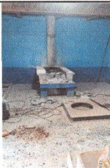
Foto 5: Mantenimiento de estufa rural.
