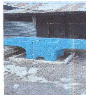
Foto 6: Sustitución de pila de cemento de dos lavaderos.
