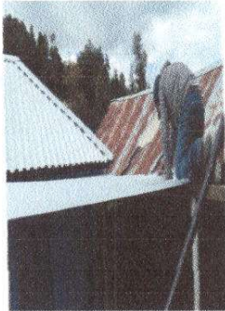
Foto1: Sustitución de lámina troquelada calibre 26.
