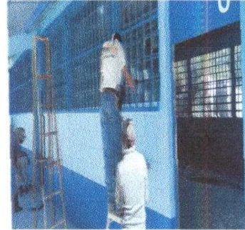
Foto 2: Sustitución de balcones de metal.
