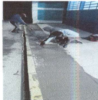
Foto 4: Reparación de plancha de concreto del patio.
