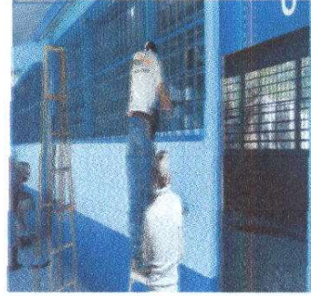
Foto 2: Sustitución de balcones de metal.
