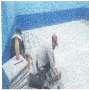
Foto 3: Sustitución de piso de cemento líquido por piso de granito.
